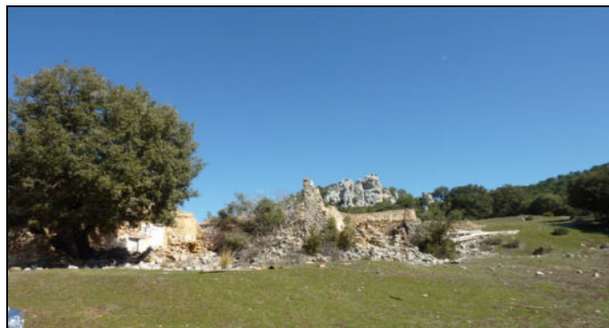
Imagen 5.2.1. La aldea de Fuentes se encuentra despoblada en la actualidad, con la mayor parte de sus edificaciones derruidas.
